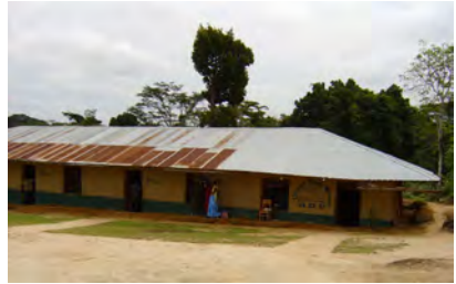
Un des deux bâtiments scolaires terminés
