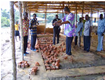
3 ème bâtiment en construction
