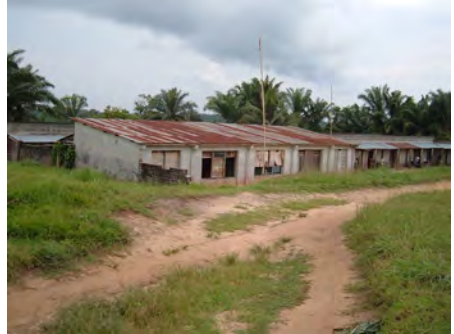
Vue d'ensemble de l'hôpital
