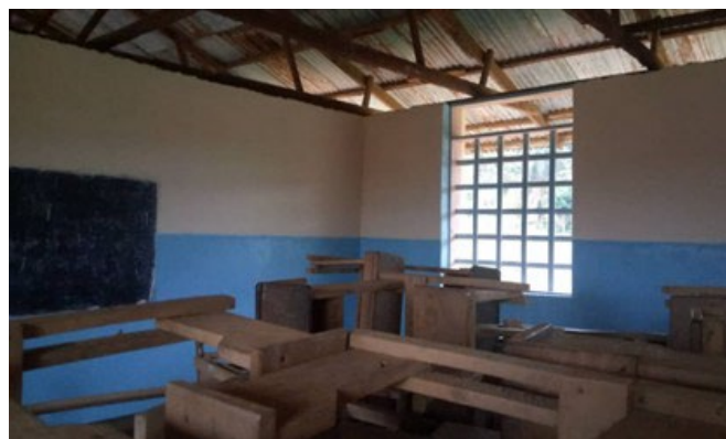
Salle de classe avant la pose des plafonds
